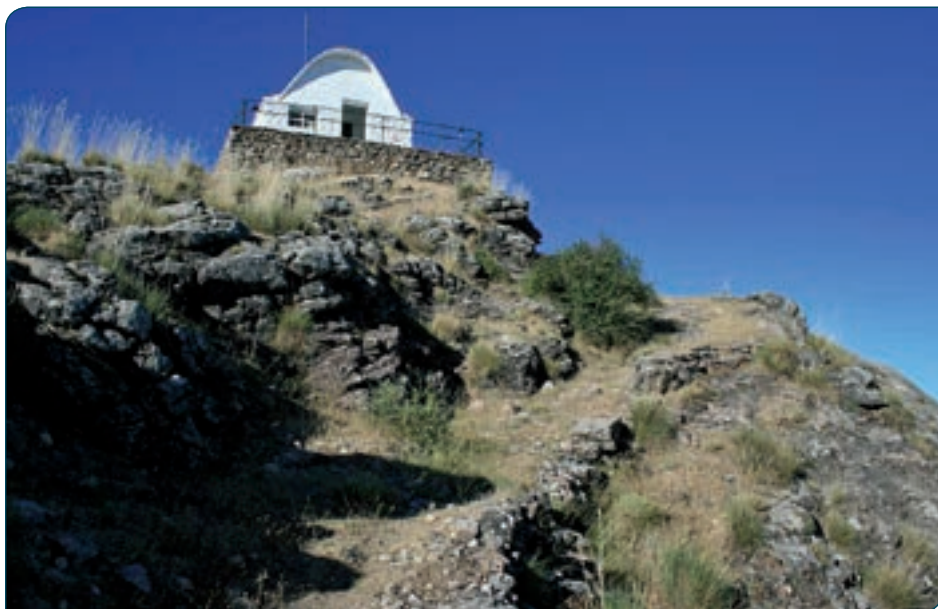
Final de derivación en caseta de fogueros
